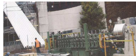
Mi-novembre, une machine-outil de 22 tonnes débarquée d'Italie prenait place à proximité du chantier afin d'y préparer une centaine de plaques en aluminium de 33,80m de longueur, nécessaires à la réalisation de la nouvelle couverture.
