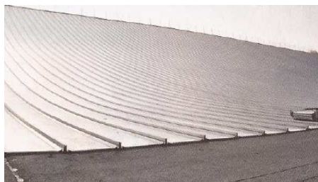
Les travaux de toiture ont figuré le gros du chantier de la piscine (ici pendant la pose et après) avec l'installation d'un revêtement spécifique, le système Riverclack® adapté aux toits en faible pente et qui garantit une étanchéité durant plusieurs dizaines d'années.
