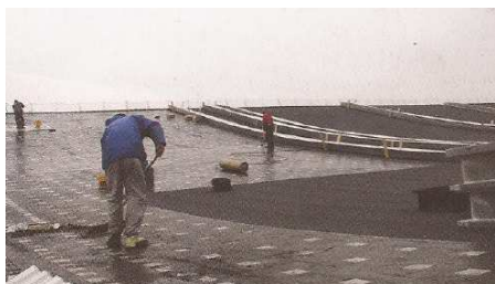
Les travaux de toiture ont figuré le gros du chantier de la piscine (ici pendant la pose et après) avec l'installation d'un revêtement spécifique, le système Riverclack® adapté aux toits en faible pente et qui garantit une étanchéité durant plusieurs dizaines d'années.
